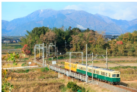
▲大木跨線橋から俯瞰 2013.11.30 東員～大泉間にて撮影
