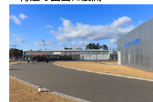
▲八木山動物公園駅駐車場屋上 は「てっぺんひろば」と命名、 八木山動物公園西門に直結
